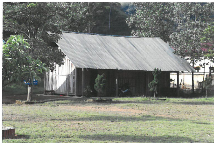
電気のない、木造・土壁の校舎
